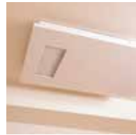
●浴室暖房乾燥機
