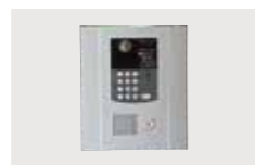
オートロックシステム
