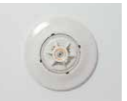
キッチンの定温式熱感知器
